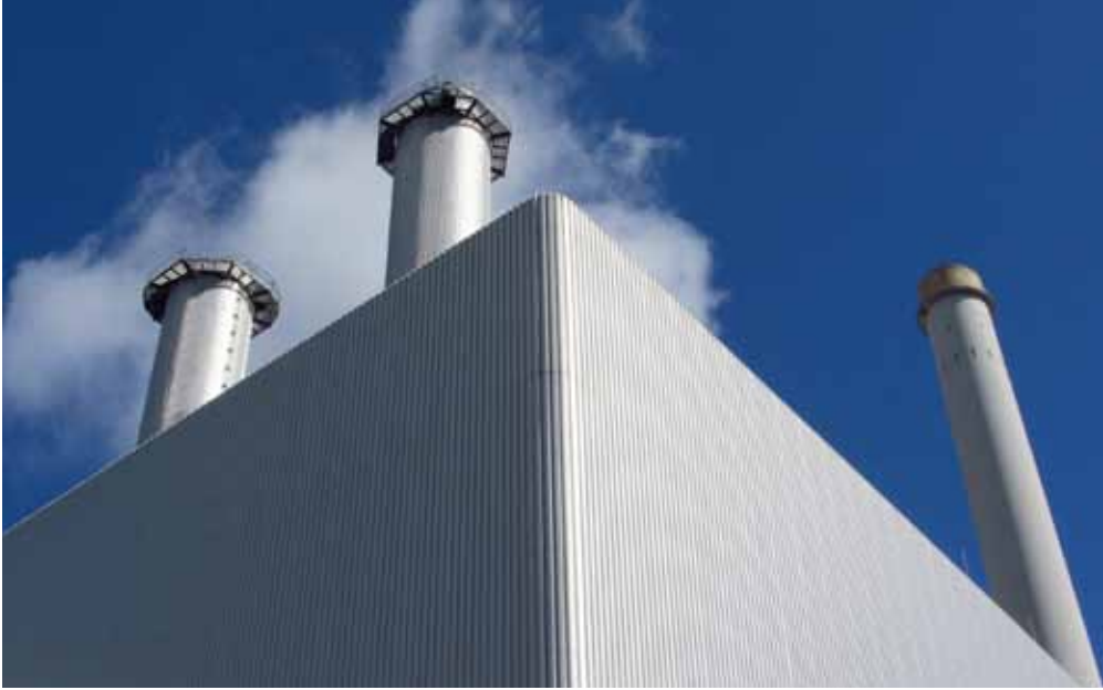
Heizkraftwerk Süd, Stadtwerke München, Foto: Daniel/Flickr
